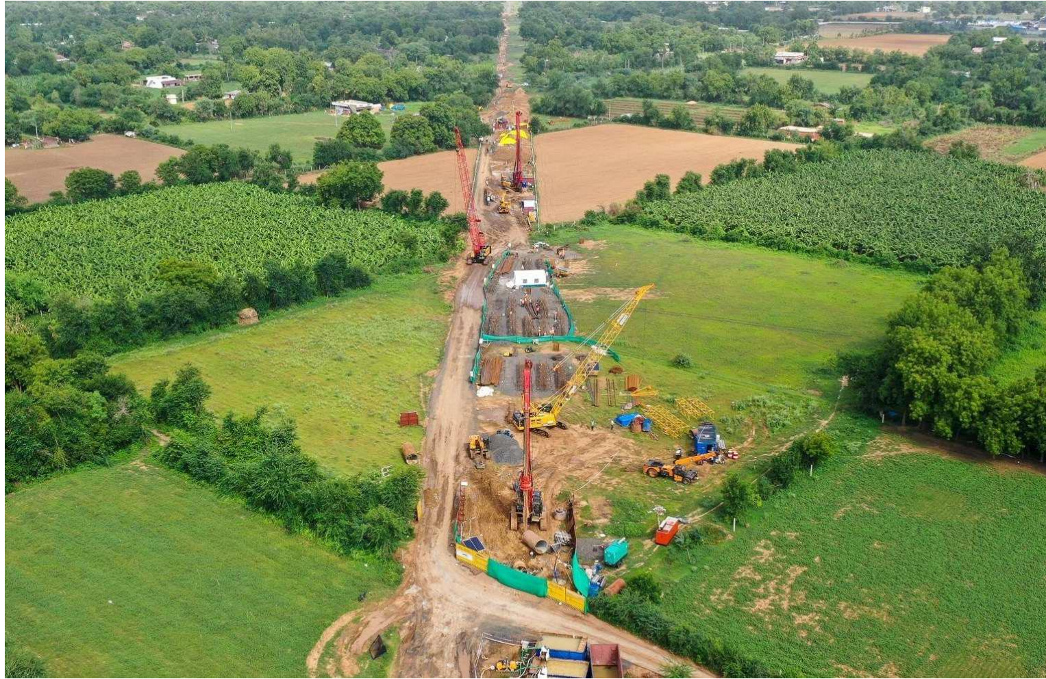
橋脚工事（ムンバイから434.5km地点）
