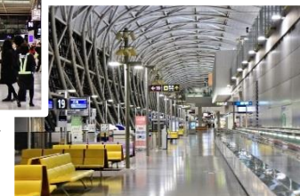
関西空港ターミナルビル
