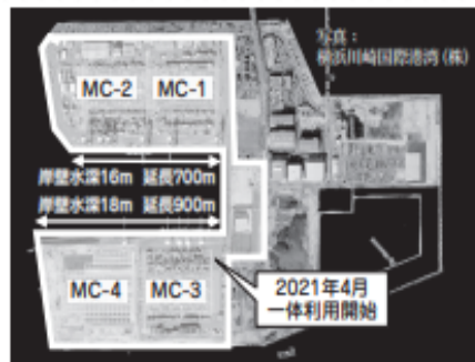
図2 横浜港南本牧ふ頭コンテナターミナル
