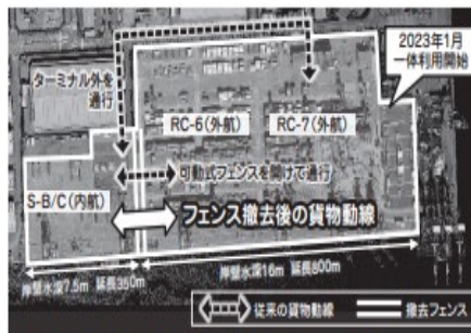
図4 神戸港六甲アイランド東側コンテナターミナル
