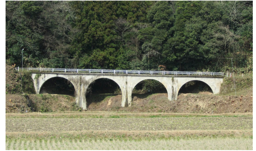
▲島根県浜田市：幻の広浜鉄道（未成線）
