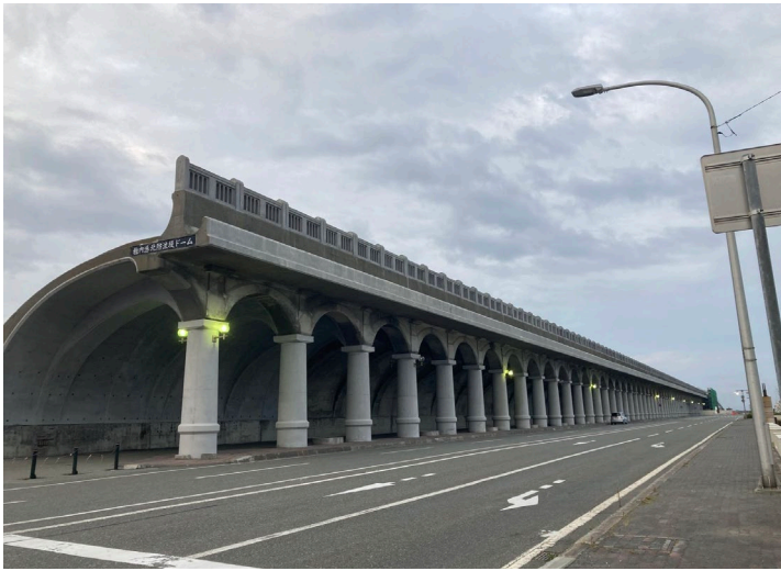
▲北海道稚内市：北防波堤ドーム
