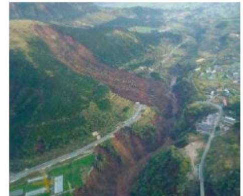
阿蘇大橋地区における斜面崩壊の様子 (熊本地震)
