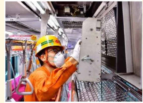
コーティング済み車内空調フィルター取付
