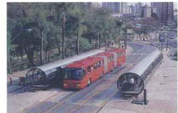
▲クリチバ市（ブラジル）のチューブバス停 （バス車体の床高さまでかさ上げたバス停で、改札口があり運賃収受も改札内に入る時に行われる）
