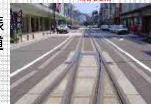
福井鉄道市内軌道線福井駅前付近 インフランド軌道を採用し、低振動・低騒音を実現
