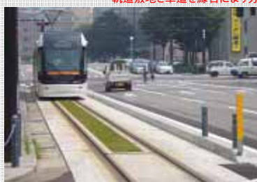
富山ライトレール富山駅北付近 軌道敷地と車道を緑石により分離
