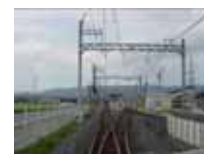
行き違い設備
