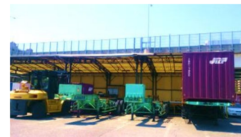
横浜本牧駅には保税蔵置場、積替小屋を設置
