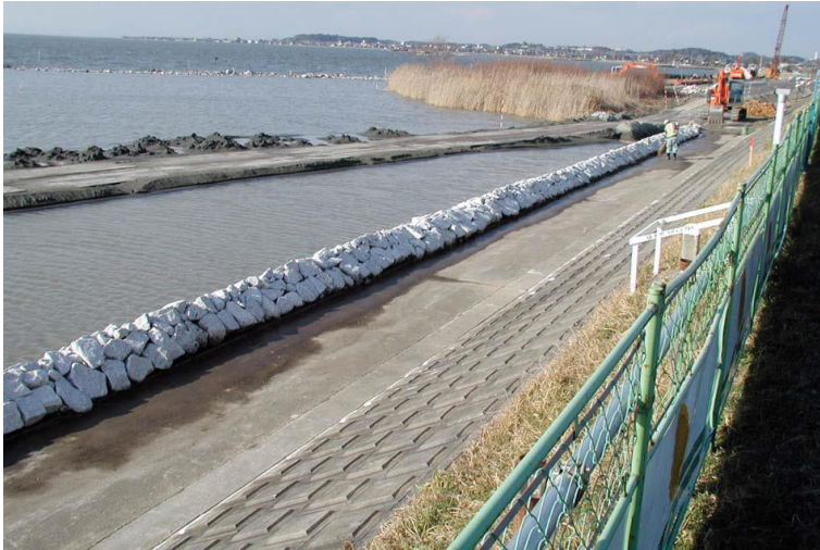
コンクリート護岸
