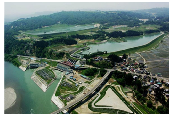
小千谷・小千谷第二発電所全景
