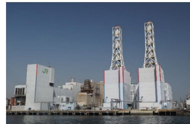
川崎発電所全景
