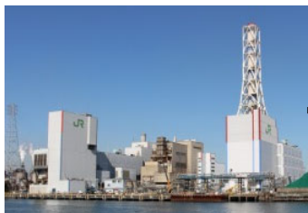
川崎発電所(火力)
