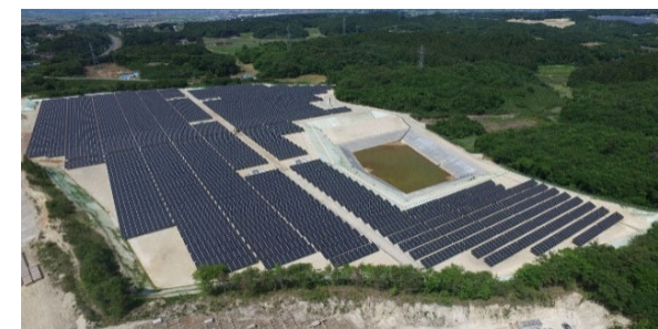
大崎三本木太陽光発電所(宮城県)
