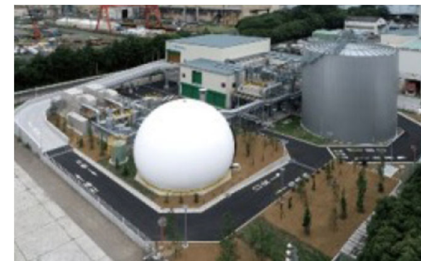
Jバイオフーズリサイクル横浜工場
