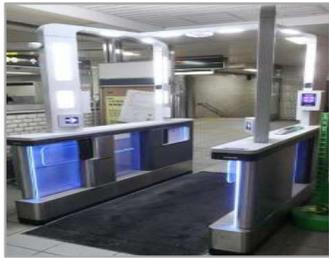
最新技術を用いた画期的な改札機能として、新たに顔認証改札機を導入し、タッチレスで圧倒的にストレスフリーな乗車サービスを提供することで、大阪・関西万博に合わせた国内の大規模鉄道では前例のない取組みを実現します。
