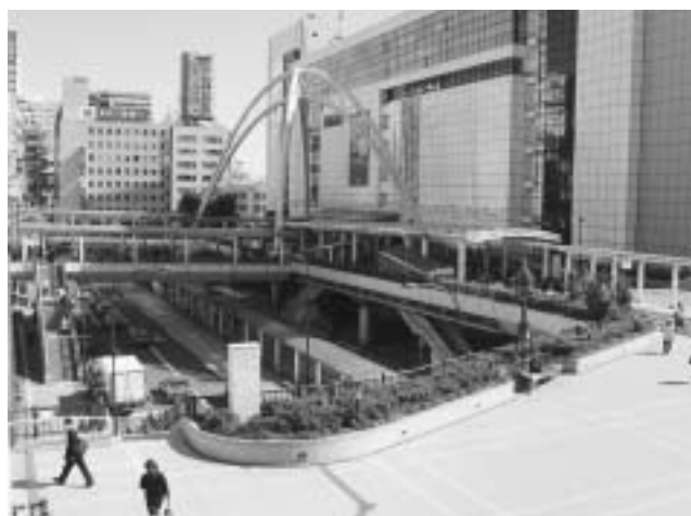
写真 2 北口駅前広場とペDESTリアンデッキ 出典：立川市資料
