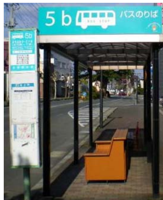
上屋やベンチの設置
