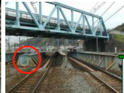
斜角桁と 横移動対策例
