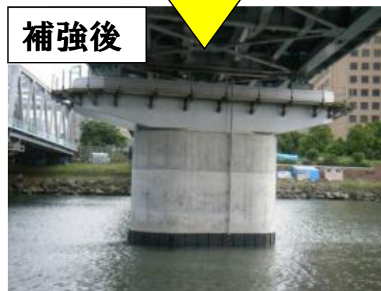
鉄筋コンクリート巻立て補強
