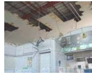
天井落下の被災事例と対策例
