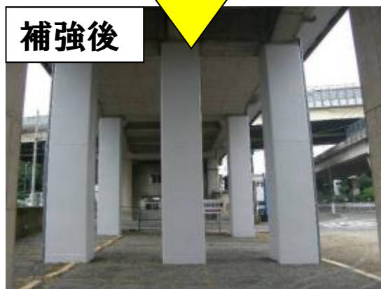
鋼板巻立て補強
