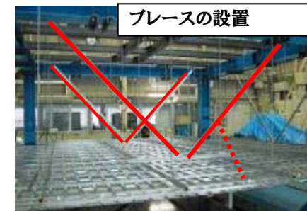
天井落下の被災事例と対策例
