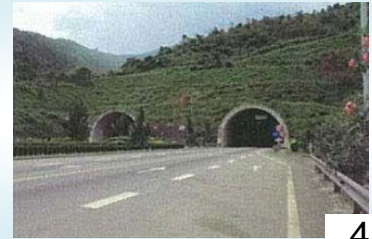
ハイバントンネル 建設事業
