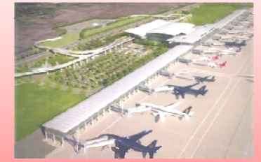
ノイバイ国際空港 第2ターミナル 建設事業
