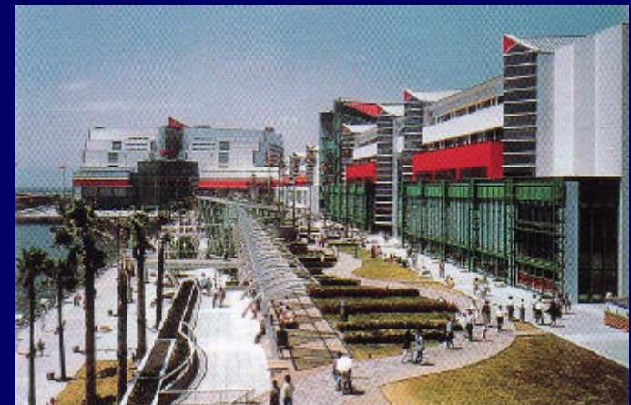
大阪港拠点整備
