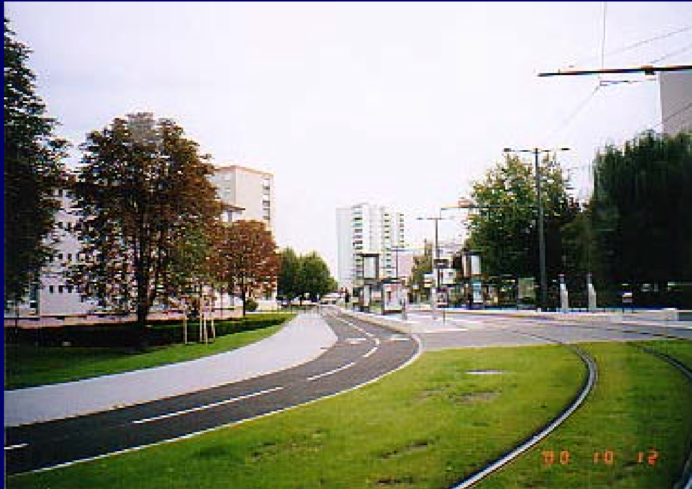
軌道面の緑化: カールスルーエ
