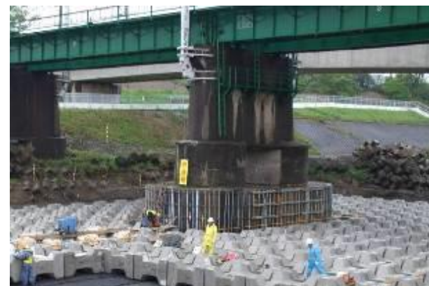
南武線 河床防護
