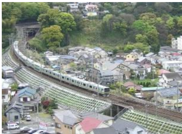
東海道線 盛土のり面防護
