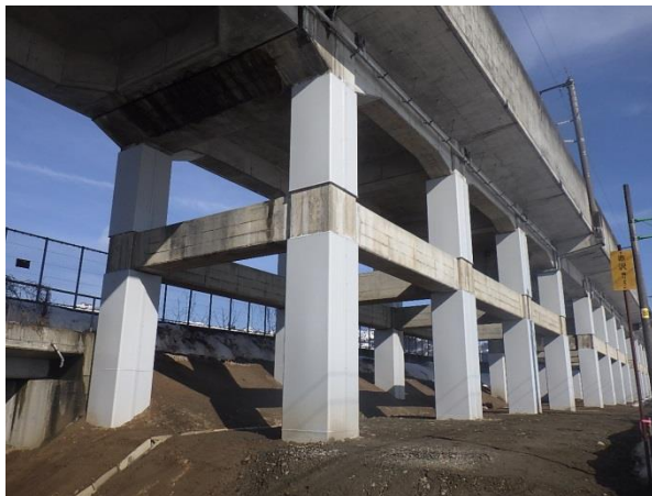
上越新幹線 高架橋柱鋼板巻立
