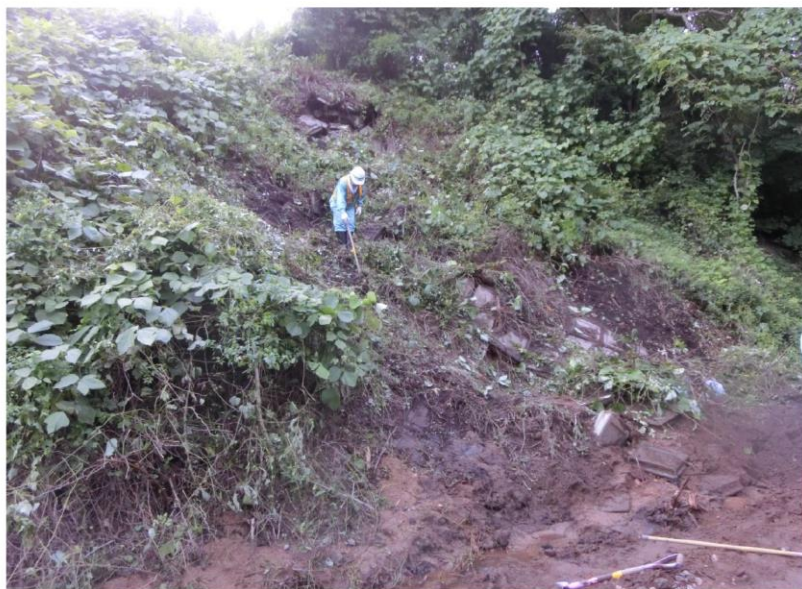
切取法面(張ブロック)洗掘土砂流入 宮古～一の渡駅間 3k070m付近左
