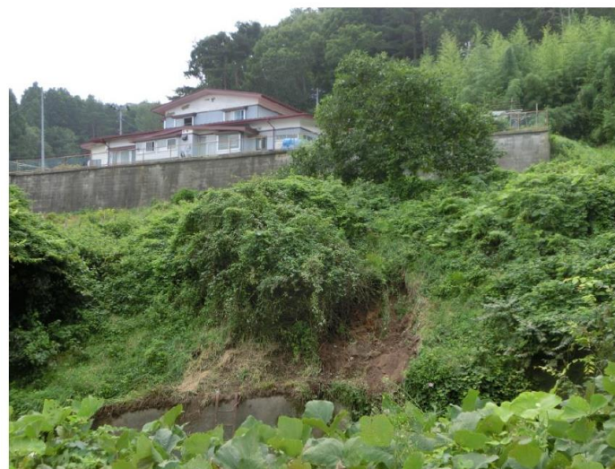
切取法面(擁壁上部)滑り土砂流入 堀内～野田玉川駅間 53k418m付近左
