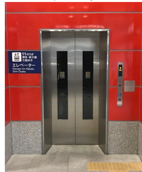
エレベーター
