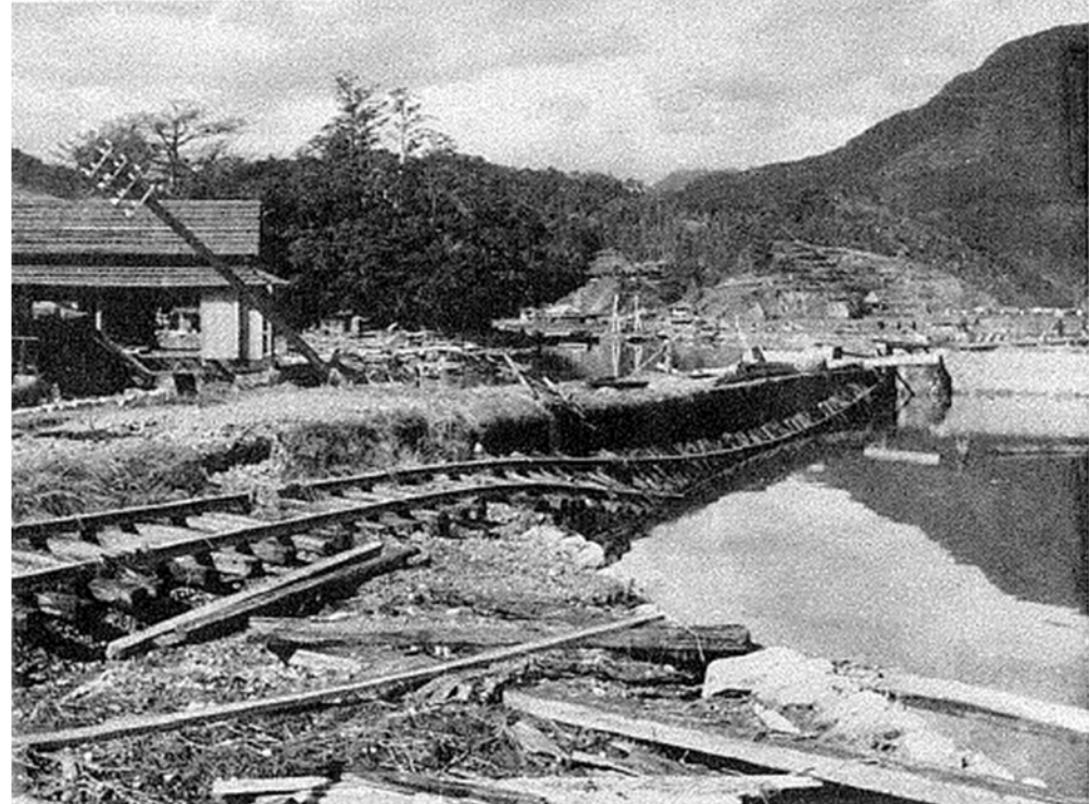
(右上) 鉄道線路の被害
