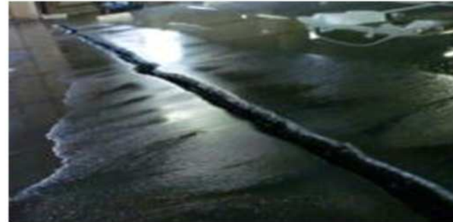
亀裂が生じた車庫出入口
