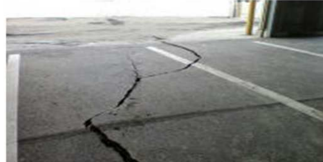
亀裂が生じた車庫出入口
