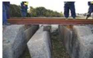
真岡鉄道真岡線 寺内～真岡間 (橋台傾斜)
