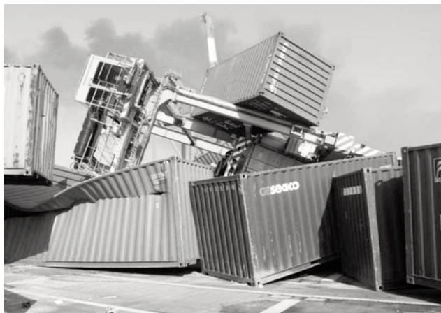
■写真—1 高砂コンテナターミナルの被災状況
