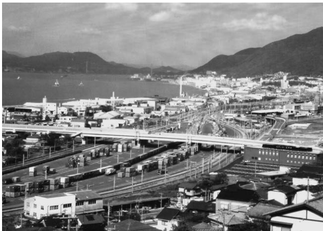
■写真—1 平成14年3月に開業した北九州貨物ターミナル駅
