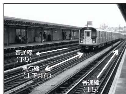
■写真-1 ニューヨーク地下鉄の3線区間 (6号線WhitlockAv駅)
