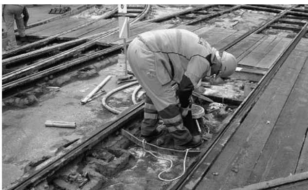
■写真—15 トラム電停付近でトラム向けの情報発信装置を地中に取り付けている様子【Bellevue付近にて撮影】
