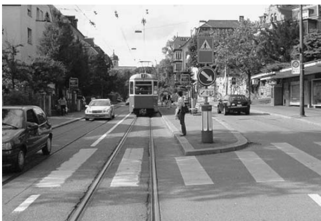
■写真—4 片方向のみのトラム島式電停。反対方向の電停は少しずらして設置される【Meierhofplatzにて撮影】
