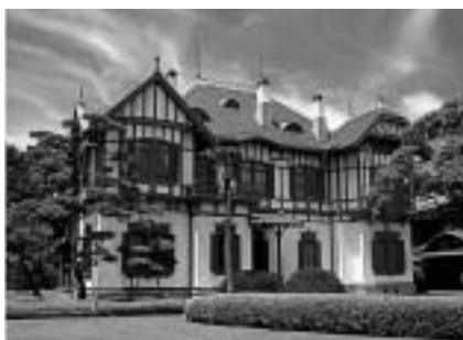
■写真—1 景観重要建造物のイメージ
