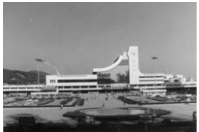
写真 3 新しく建設された徐州新駅
