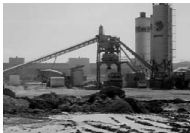
写真 1 建設現場内に設けられた生コン製造工場
