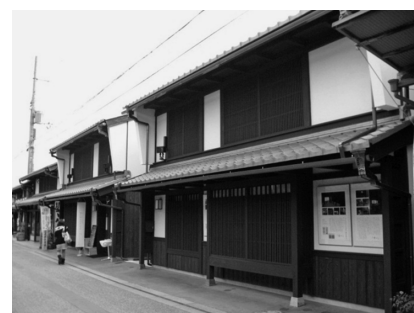
■写真2 滋賀県長浜市 (まちなかの魅力強化のため、宿泊施設(写真)、ギャラリー・回廊、飲食施設、まちの駅などを同時多発的に整備)
