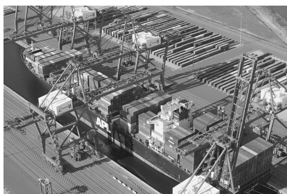
■図-17 アムステルダム港セレス・パラゴン・ターミナル (コンテナ船を両舷から9基のクレーンで同時荷役を行なうことができる革新的ターミナル)
