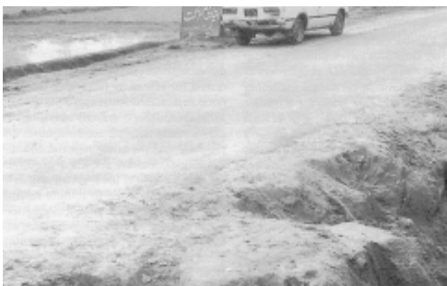
写真 - 1 パキスタンの農村道路の現況 維持管理が必ずしも充分ではなく、状態が極度に悪化した区間も存在している。
