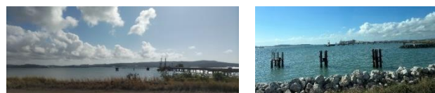
グラッドストーン港の概観
