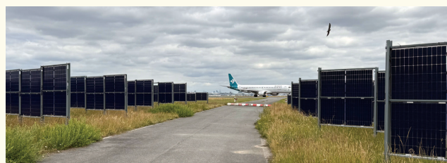
滑走路近傍に設置された衝立型の太陽光発電施設
