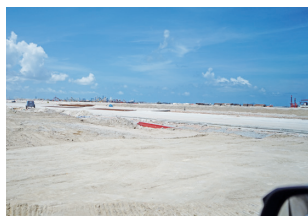
図7 造成中の土地
