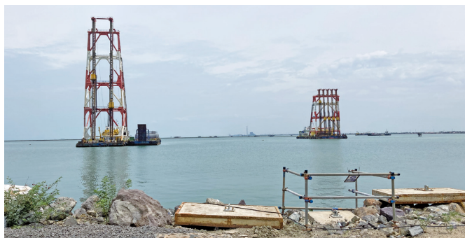
図3 工事の状況（2023年筆者撮影）
