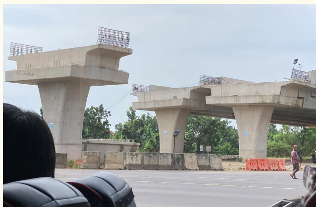
建設中のアクセス高速道路
