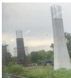
図5 サラブリ・パクチョン間 下部工施工状況
