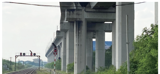
図9 ARLラックラバン駅 高架橋幅部
