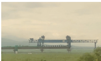
図6 パクチョン・ナコンラチャシマ間 上部工架設状況
