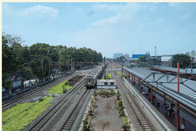
写真5 プカシ駅構内の様子。左側が都市間列車用、右側が通勤電車の線路であり、緩急分離が行われている。プカシ駅から線路共用区間となる
