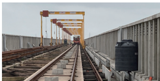
図-7 本線内の仮軌道敷設
