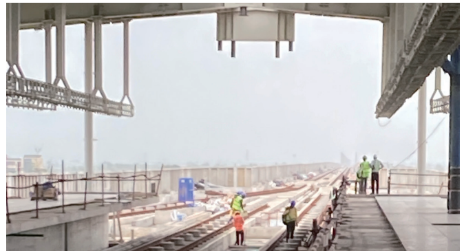
図-4 スーラト駅内の建築工事および軌道工事
