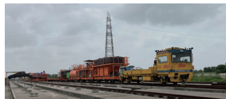
図-8 教育訓練施設における訓練線と軌道工事車両
