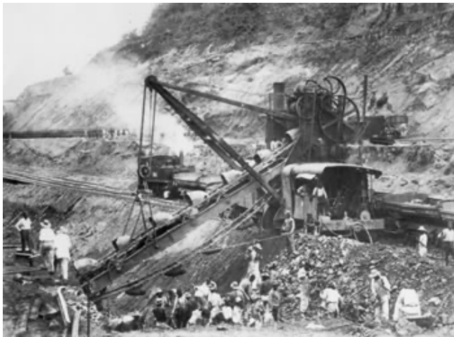
図ー 1 C 社によるパナマ運河の建設の様子 2
