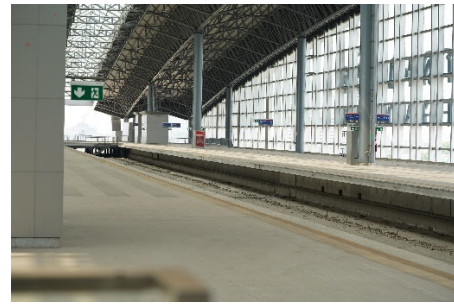
バンスー中央駅(建設中のホーム)
