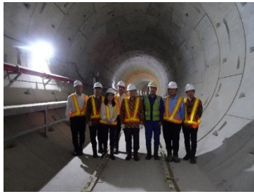
ジャカルタ MRT フェーズ2モナス駅建設現場
