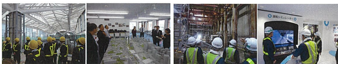
JR東日本高輪ゲートウェイ駅新設工事
