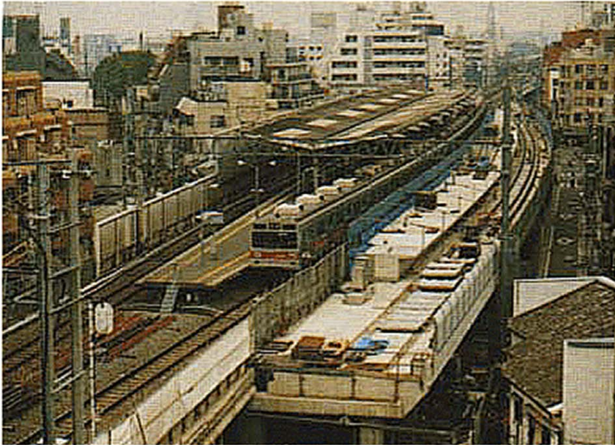
（東急東横線新丸子駅付近）
