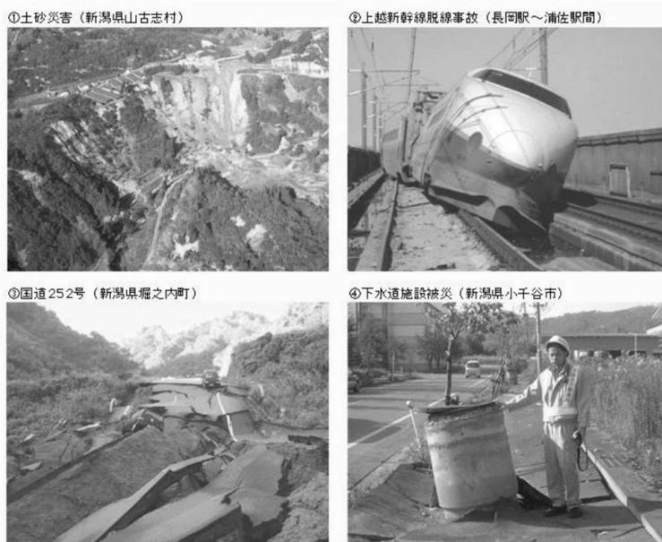
図 9-17 新潟中越地震の被害状況
