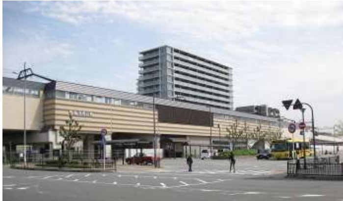
洛西口駅:新駅・高架化・区画整理事業
