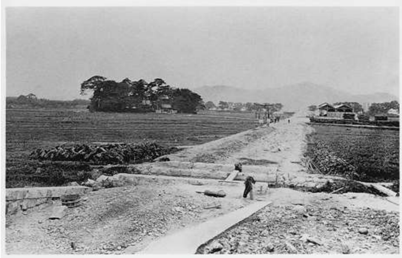
池田駅付近の線路敷設工事(1909年)
