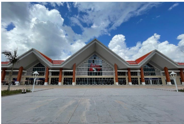
写真-12 ボーテン駅外観
