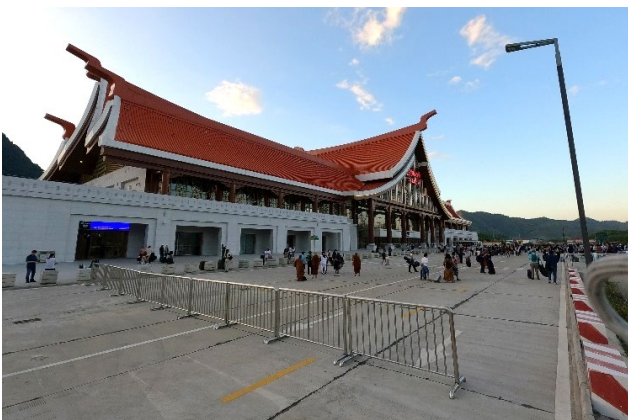
写真-7 ルアンパバーン駅外観
