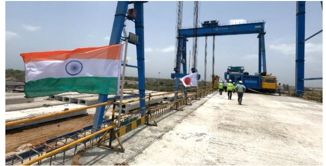
写真-9 高架上に設置されたインドと日本の国旗
