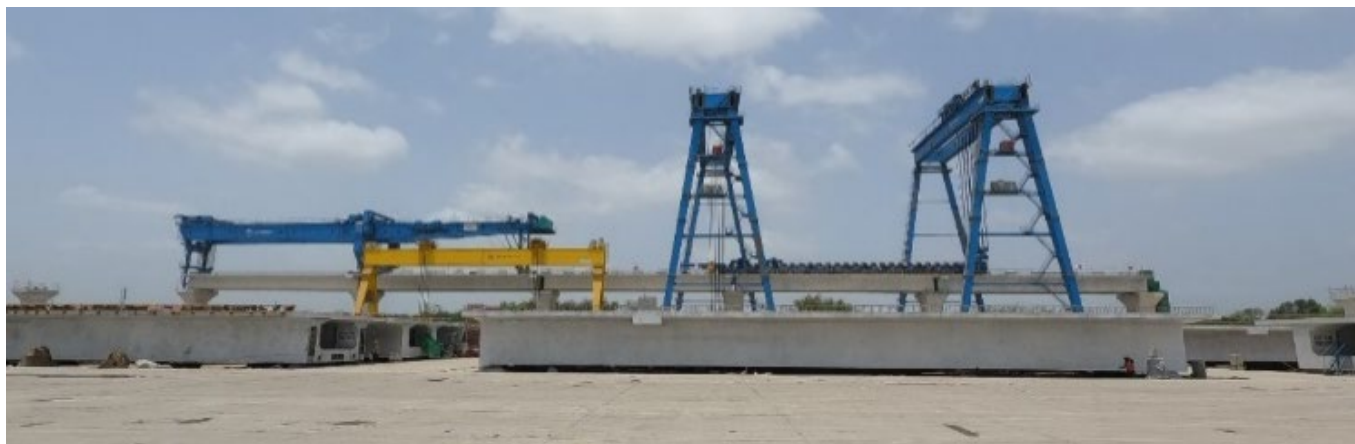
写真-7 フルスパンの桁架設ヤード全景
