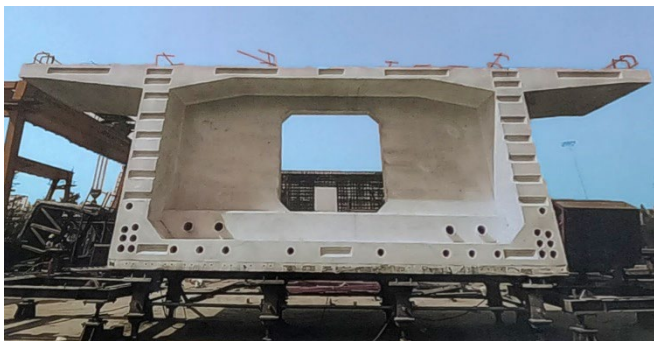
写真-1 セグメント桁の横断面
