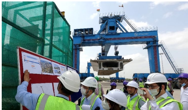
写真-5 フルスパンの桁の吊上げ状況
