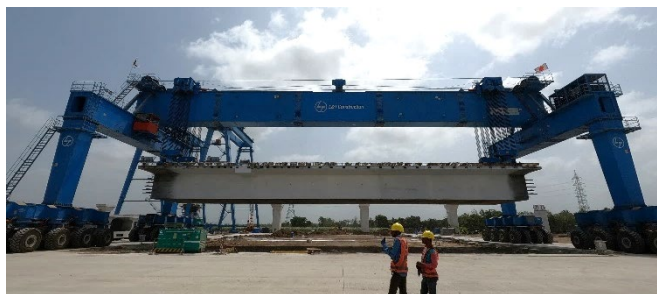
写真-6 ストラドルキャリア全景
