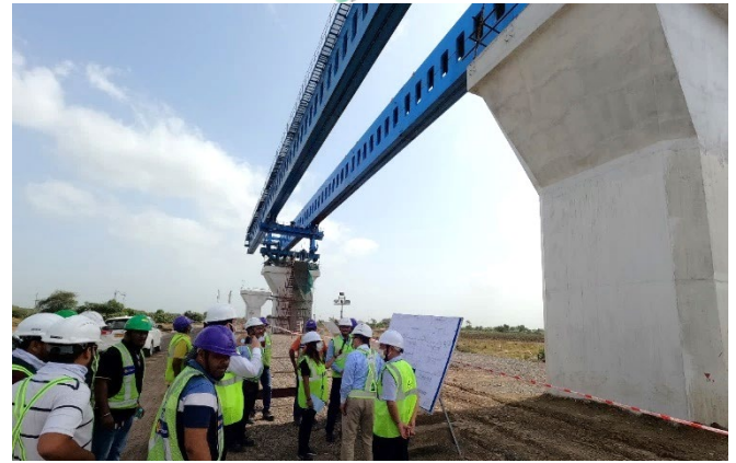
写真-3 橋脚上に設置された架設桁
