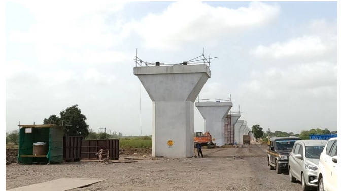
写真-4 完成した橋脚の様子
