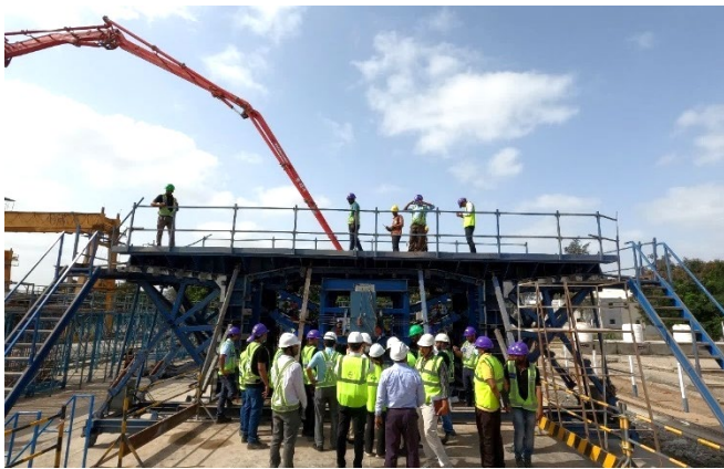
写真-2 コンクリート打設状況
