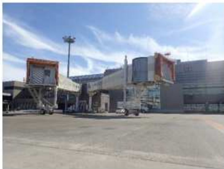
搭乗橋の外観※
