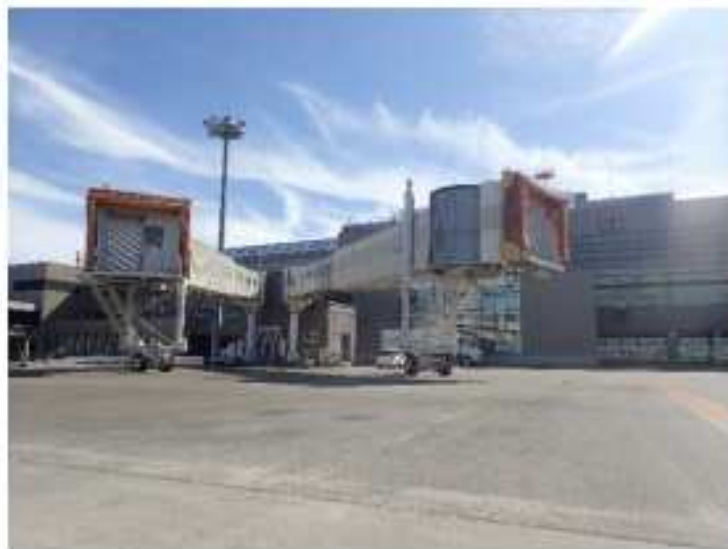
搭乗橋の外観※
