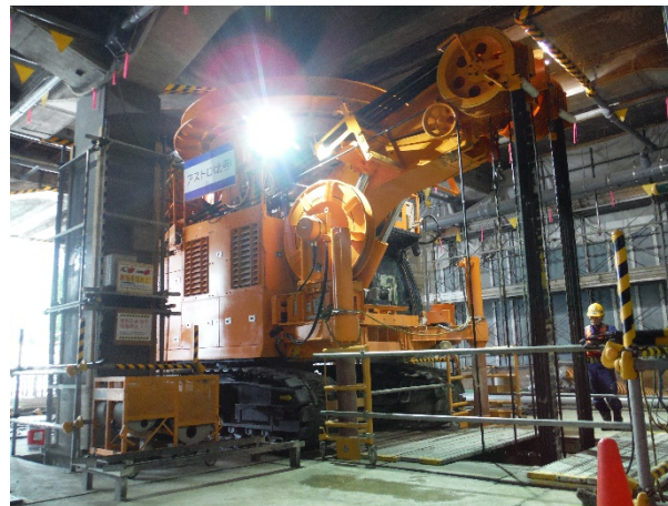
地中連壁工事(新幹線部)
