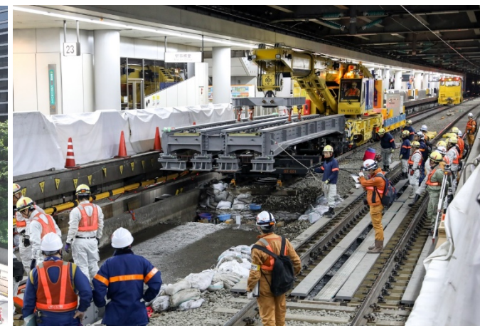
工事桁架設(新幹線軌道部)
