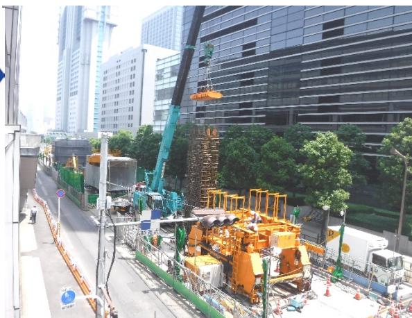
地中連壁工事(南工区)
