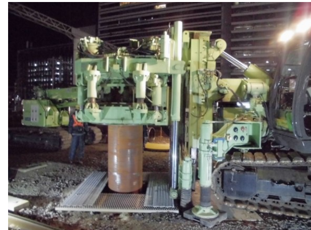
工事桁の基礎杭打設(在来線部)
